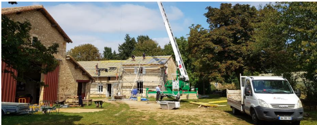
Réfection de la toiture sur une partie des habitations et futures habitations
