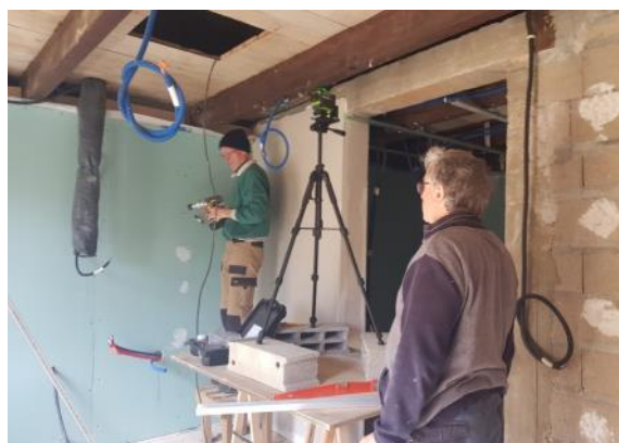
L'engagement des bénévoles « travaux et maintenance » a représenté pas moins de 794 heures en 2024 ! Un appui crucial !
