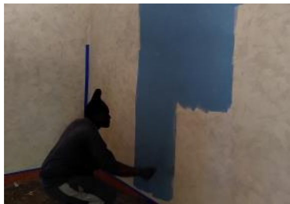
Réfection de la salle à manger de la Maison Henri, par les bénévoles et résidents
