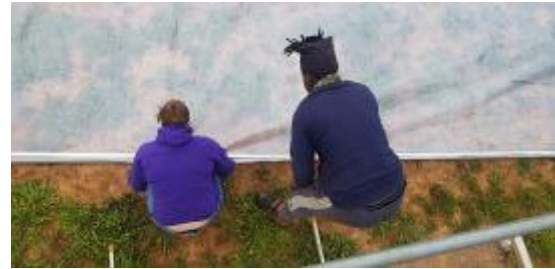
Montage des serres
